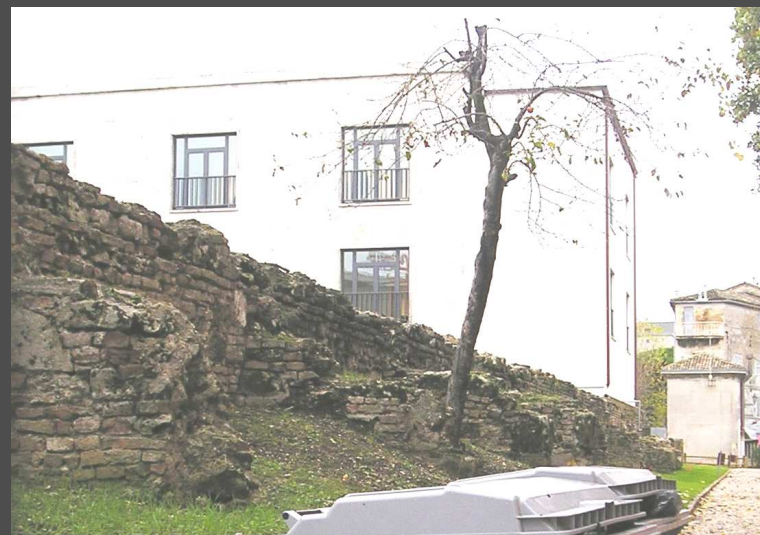
Contrafforti e terrapieno delle mura presso il baluardo della Penna
