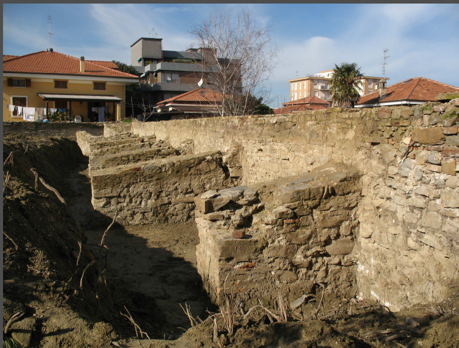
Contrafforti del baluardo del Porto
