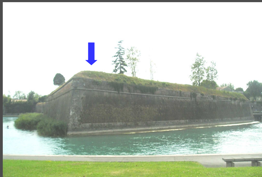
Il baluardo di Peschiera del Garda. E' visibile la rifinitura superiore in terra
